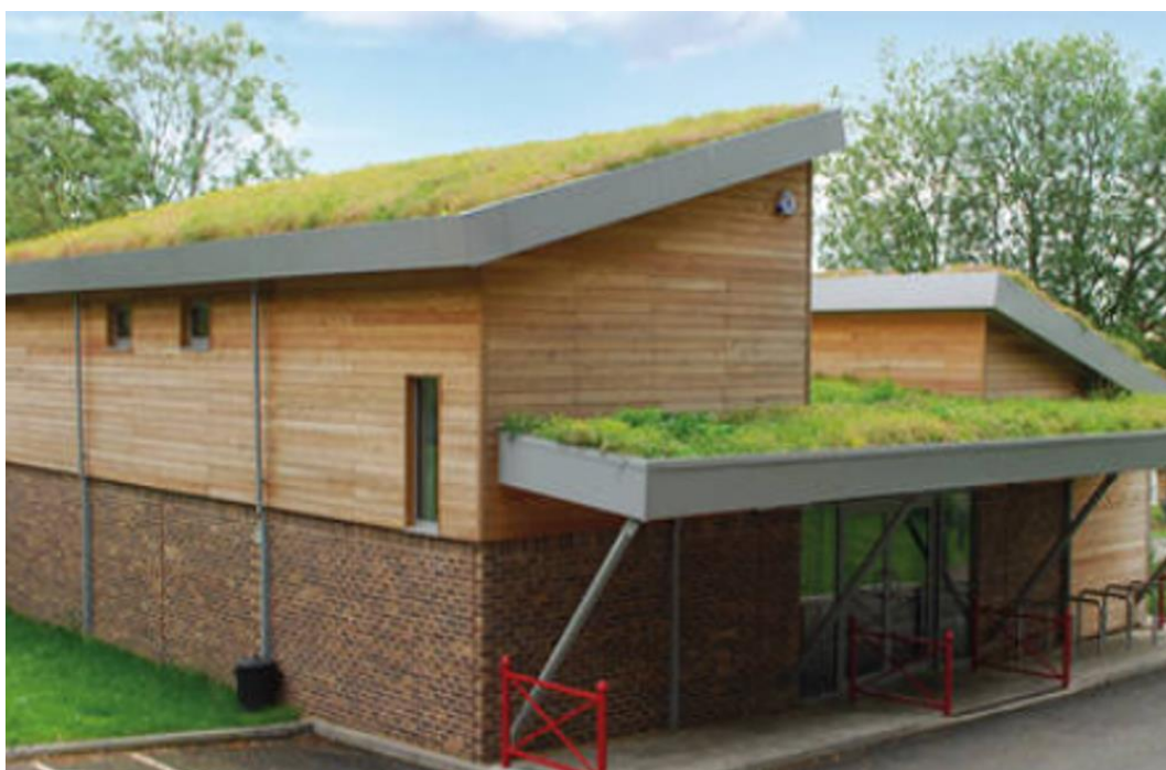
Figur 11. Sedumtak kan anläggas både på platta och lutande tak (Svenska Naturtak AB, 2018).
