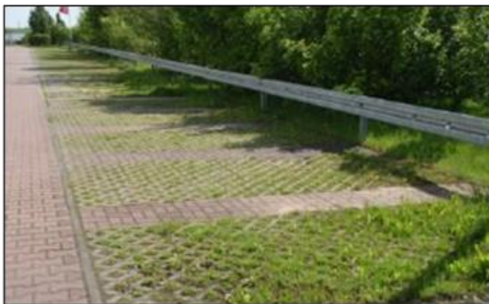
Figur 2. Exempel på genomsläpplig betongbeläggning med gräs.
