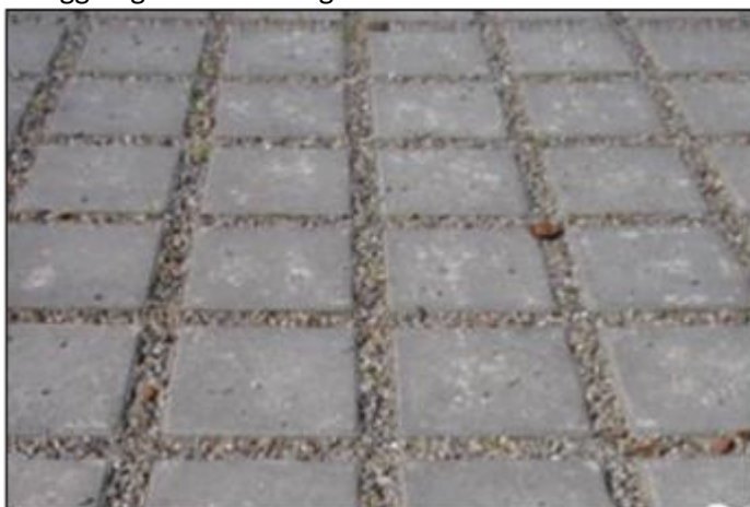
Figur 1. Exempel på genomsläpplig betongbeläggning med grusfogar.
